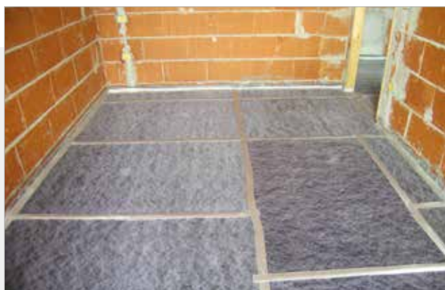
Isolamento acustico a pavimento
