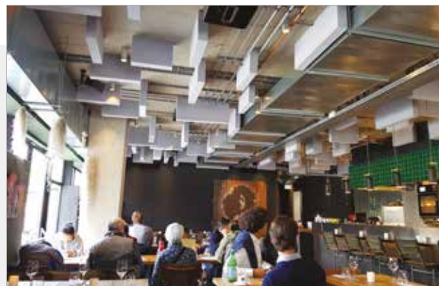
Correzione acustica all'interno di un locale pubblico
