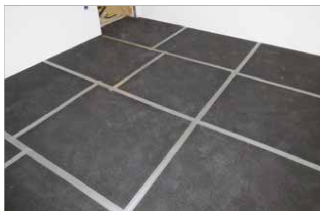
Bonifica del pavimento per una sala musica
