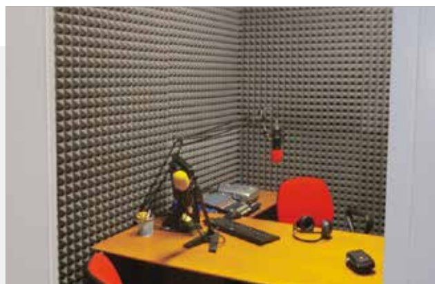
Coibentazione in una sala di registrazione radiofonica
