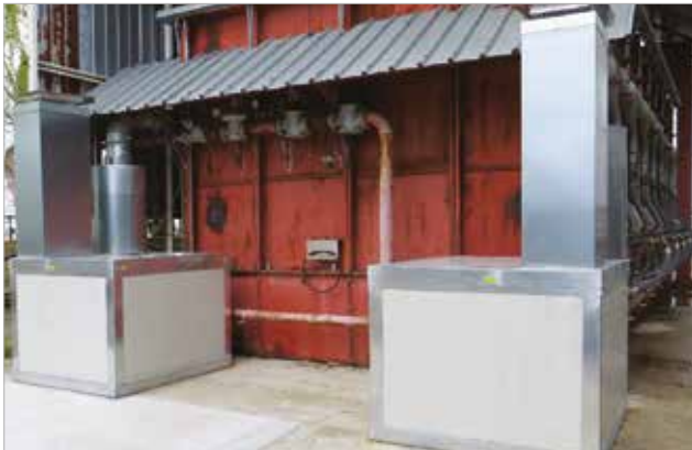
Bonifica acustica di un impianto industriale (ventilatori autocassonati)
