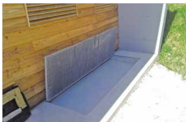
Bonifica acustica delle bocche di lupo in una centrale idroelettrica
