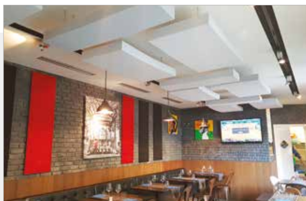
Correzione acustica all'interno di un locale pubblico
