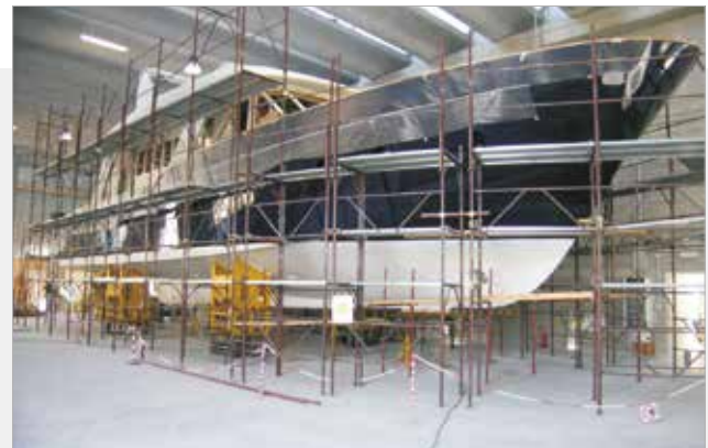
Isolamento acustico del vano tecnico/motore in uno yacht da diporto
