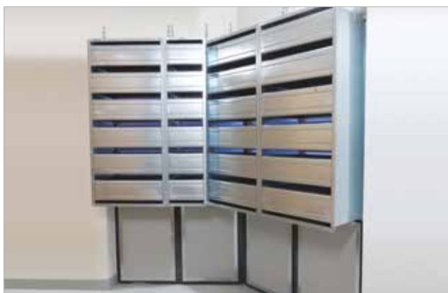
Bonifica acustica delle porte di una centrale idroelettrica con applicazione di silenziatori a setti
