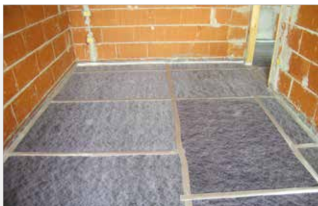
Isolamento acustico a pavimento
