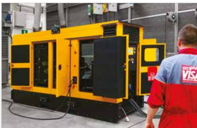
Isolamento acustico della cabina di un gruppo elettrogeno
