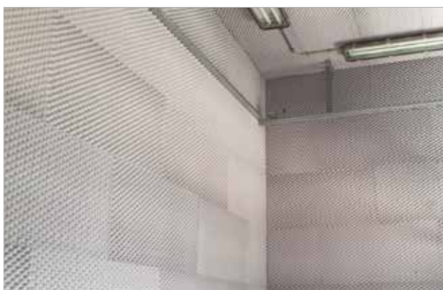
Bonifica delle pareti divisorie di una sala tecnica
