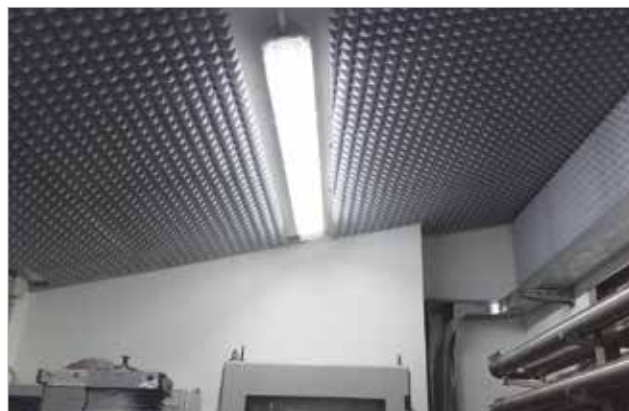
Bonifica acustica di una sala tecnica
