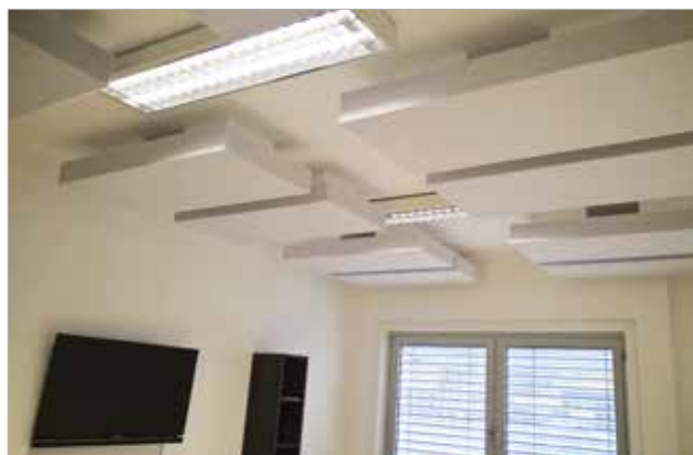
Correzione acustica all'interno di una sala riunioni
