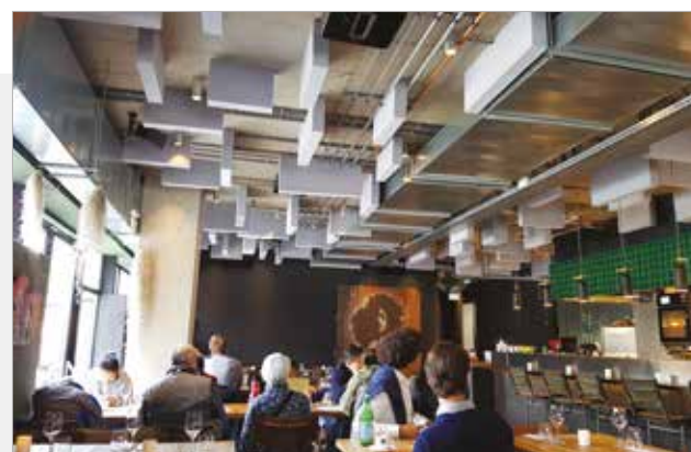
Correzione acustica all'interno di un locale pubblico
