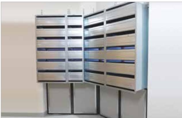
Bonifica acustica delle porte di una centrale idroelettrica con applicazione di silenziatori a setti
