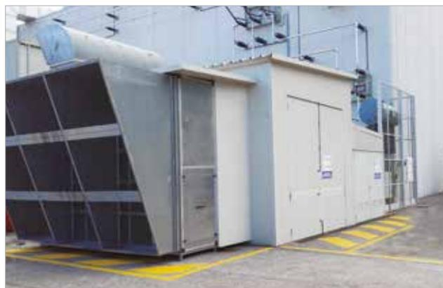
Silenziamento di un box contenente un generatore elettrico
